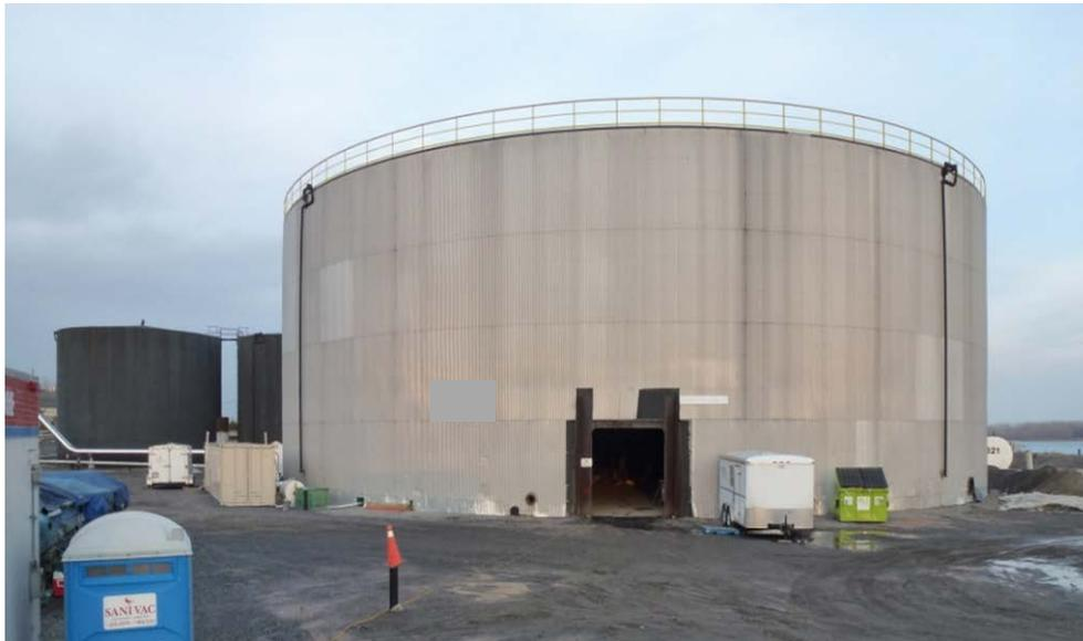
**Figure 2. Réservoir à l'origine de la fuite de xylène dans le sol sous-jacent**
