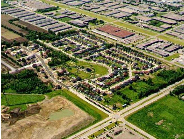
Figure 3.31 Le projet domiciliaire du Nouveau Saint-Laurent. Source : Extrait de photographie aérienne oblique de Saint-Laurent, 2000.
