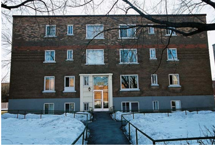
Figure 3.15 Maison à appartements ou Walk-up , boulevard Décarie. Source : L'auteur.
