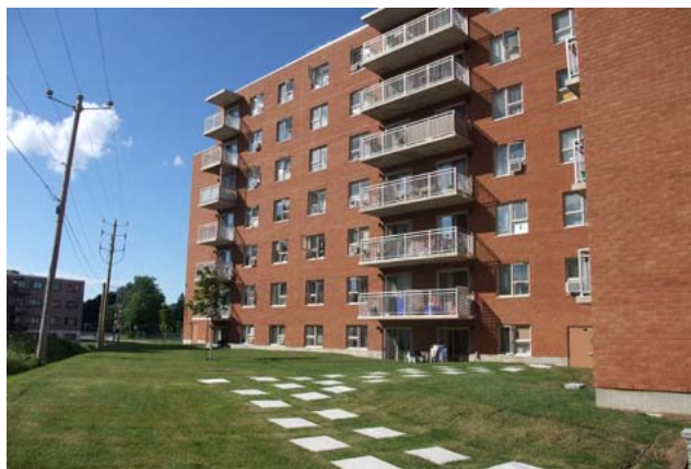
Figure 35 : Photo de la façade arrière et de la cour
