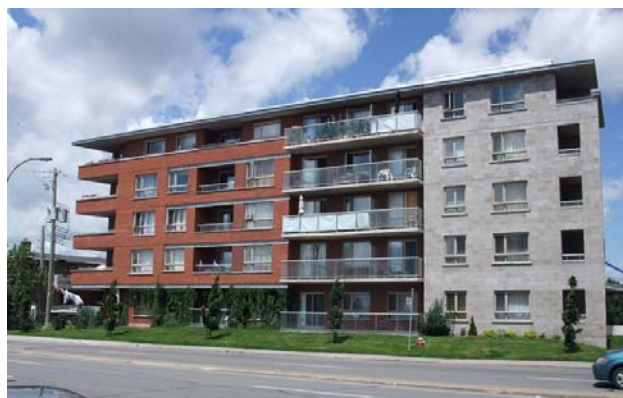
Figure 40 : Photo de la façade sud, boulevard Viau
