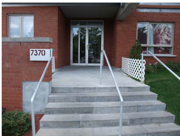
Figure 42 : Photo de l'entrée de l'immeuble
