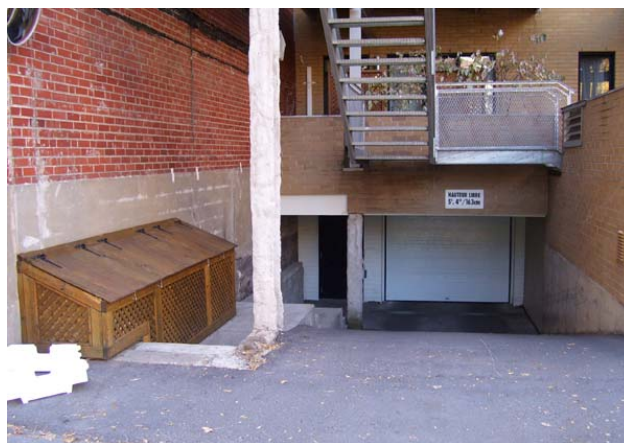
Figure 84 : Photo de l'accès au garage en sous-sol
