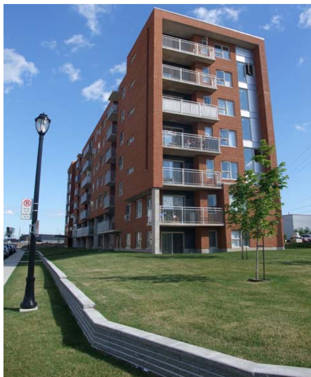
Figure 28 : Photo de l'aménagement extérieur du site
