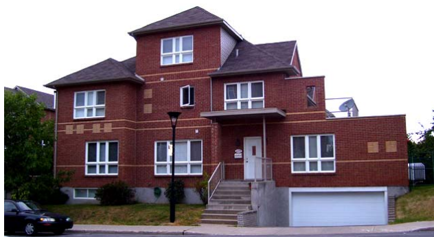
Figure 57 : Photo de la façade latérale des maisons en rangée
