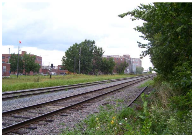
Figure 71 : Photo de la cour de triage
