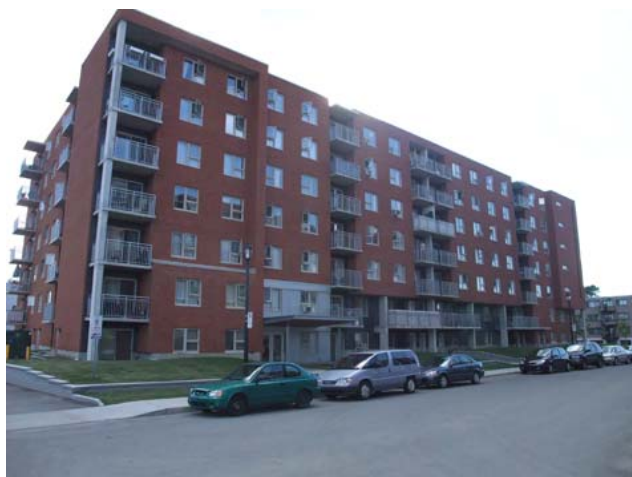
Figure 29 : Photo de la façade principale, rue Crevier
