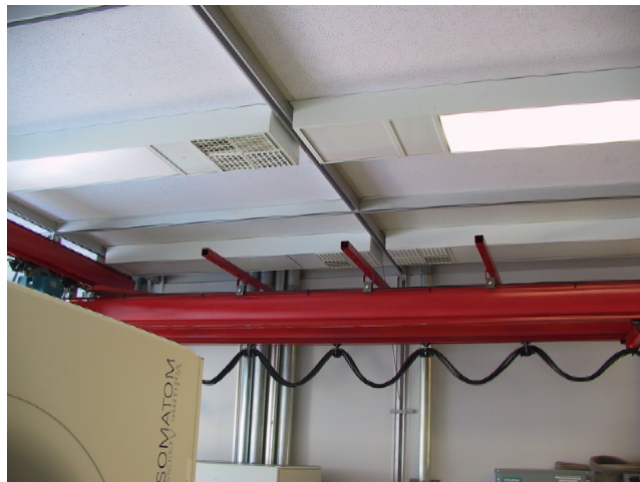
Fig. F.1 – Attaches de fixation du canal au pont roulant.
