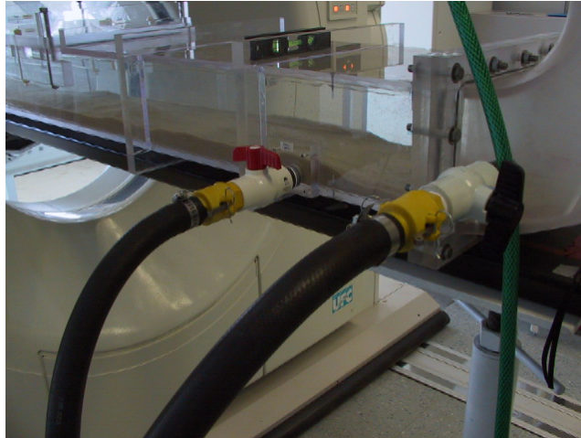
Fig. F.19 – Vannes du dispositif de drainage.
