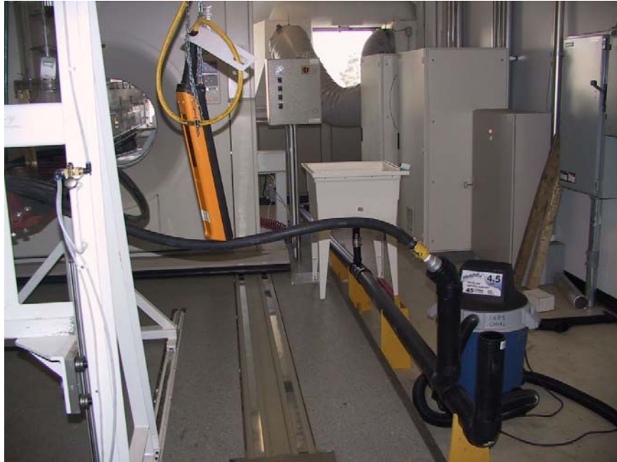
Fig. F.21 - Dispositif de drainage de surface avec évier.
