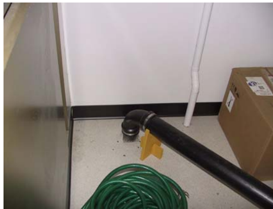
Fig. F.17 – Raccordement au réseau du drainage de surface.
