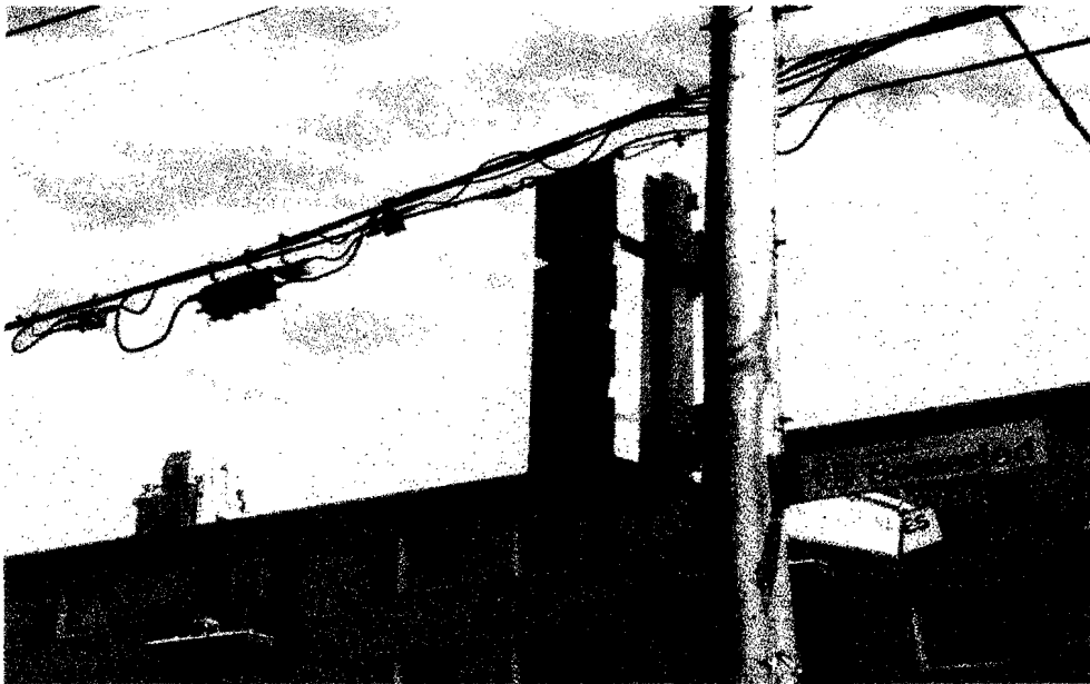
Figure 5.4 Équipements et câbles de Vidéotron sur les poteaux d'Hydro-Québec
