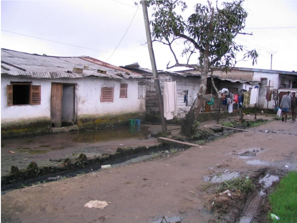
Figure 35: Occupation d'une zone inondable dans le quartier Mambanda
