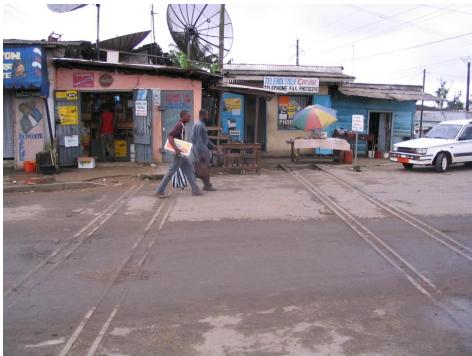
Figure 34: Invasion d'un ancien chemin de fer dans le quartier Mambanda à Bonabéri
