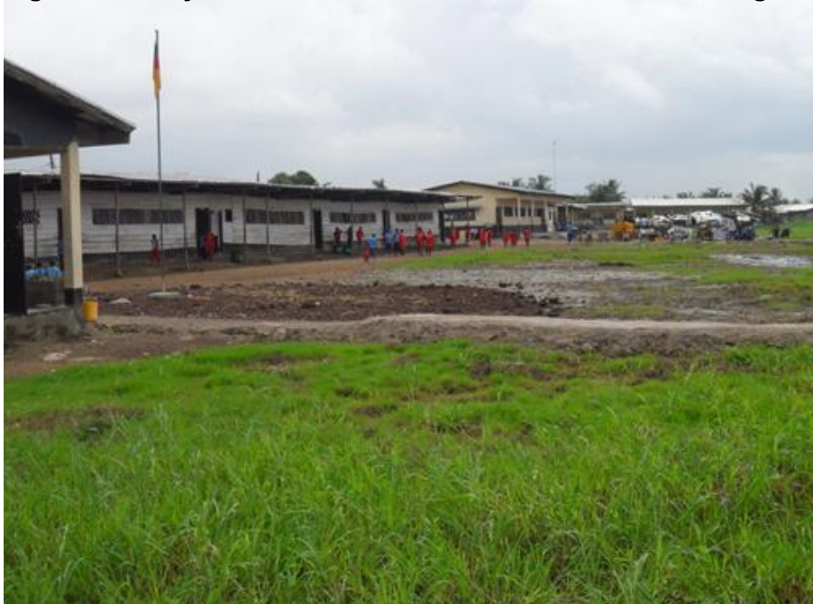
Figure 25: Le lycée de Mambanda construit en zone marécageuse
