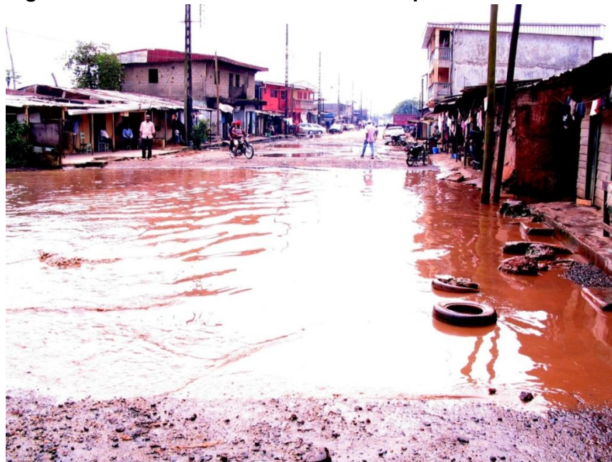
Figure 28: État de la chaussée en saison pluvieuse
