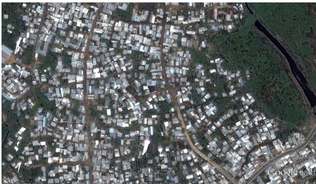
Figure 19: Vue aérienne d'un quartier périphérique à étape (Makepe)
