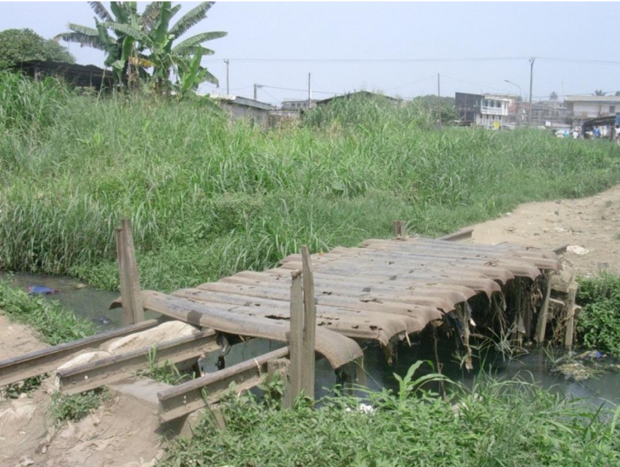
Figure 26: Ouvrage de franchissement d'un drain construit par les résidents
