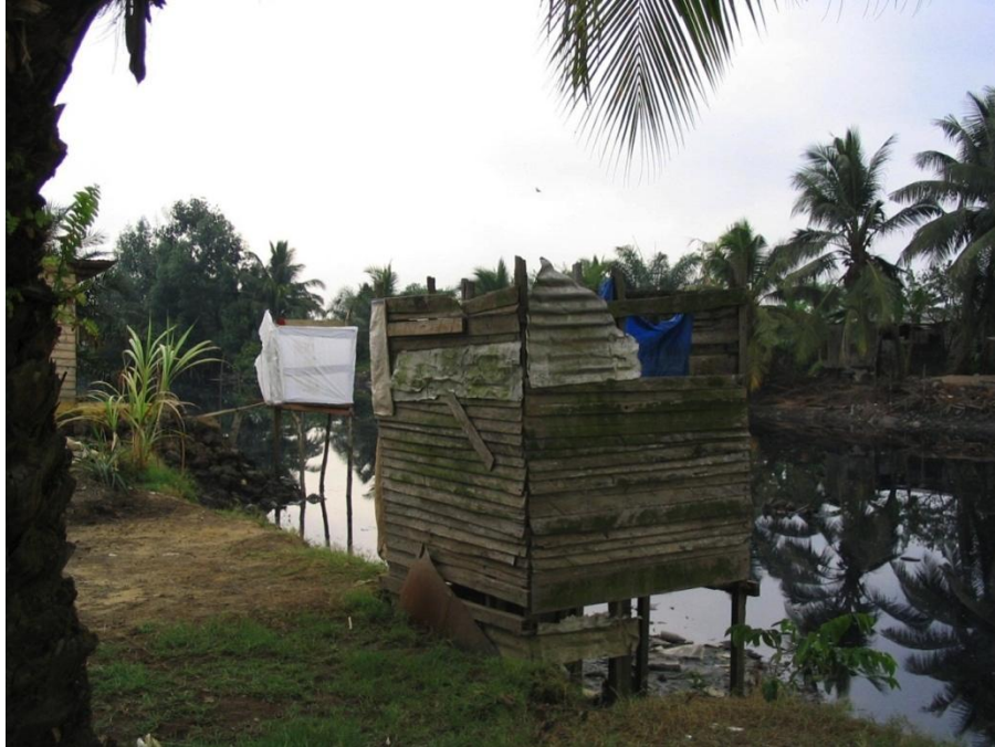
Figure 21: Exemple de latrines sur pilotis dans le quartier de Mambanda
