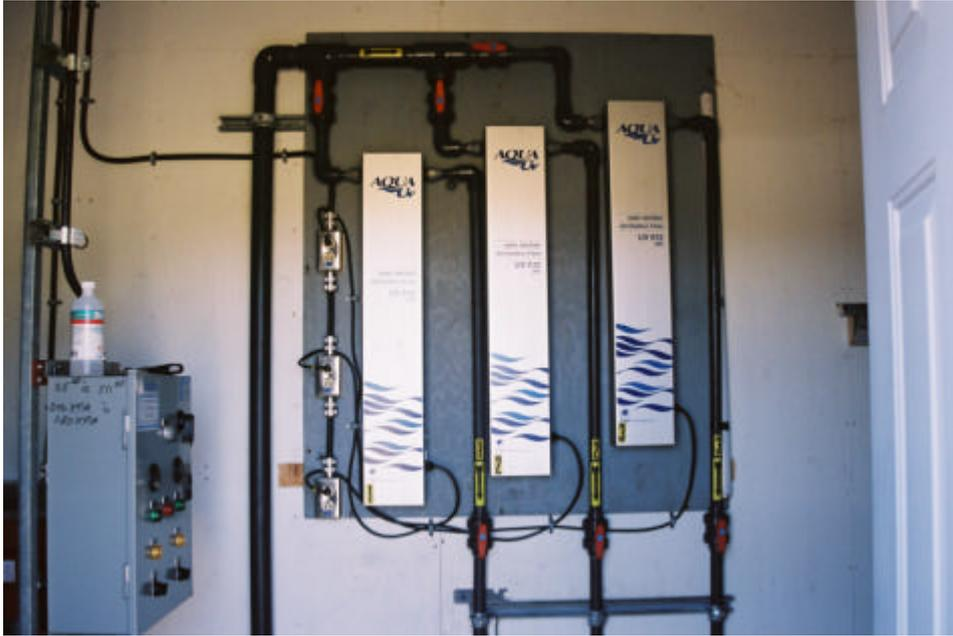
Photo B.8 Système UV en place à Aylmer Sound.
