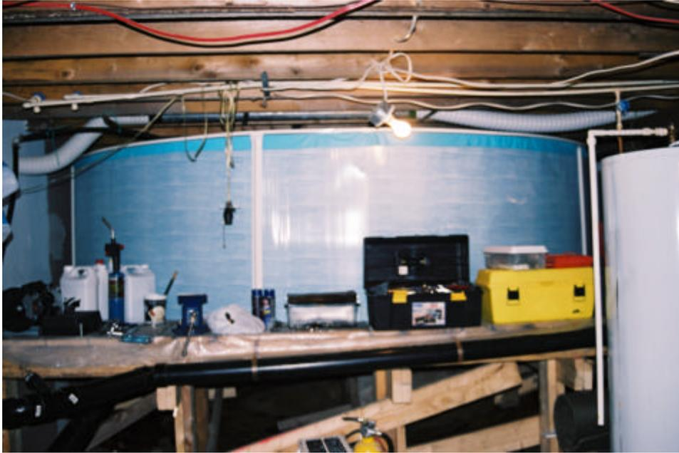
Photo B.16 Exemple de « réservoirs résidentiels » utilisés pour stocker l'eau à Harrington Harbour.
