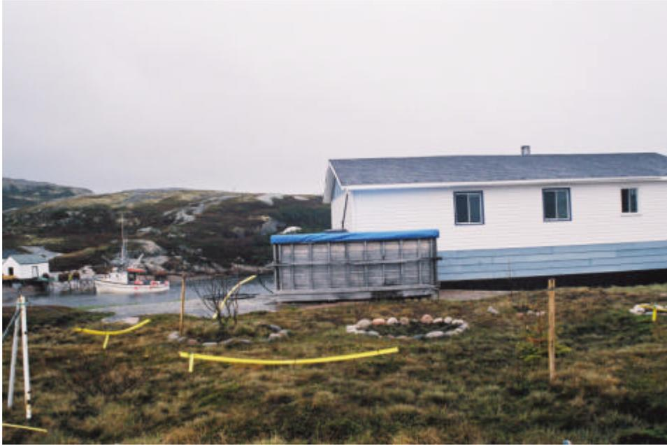
Photo B.20 Système de collecte des eaux de pluie à Baie-des-Moutons.
