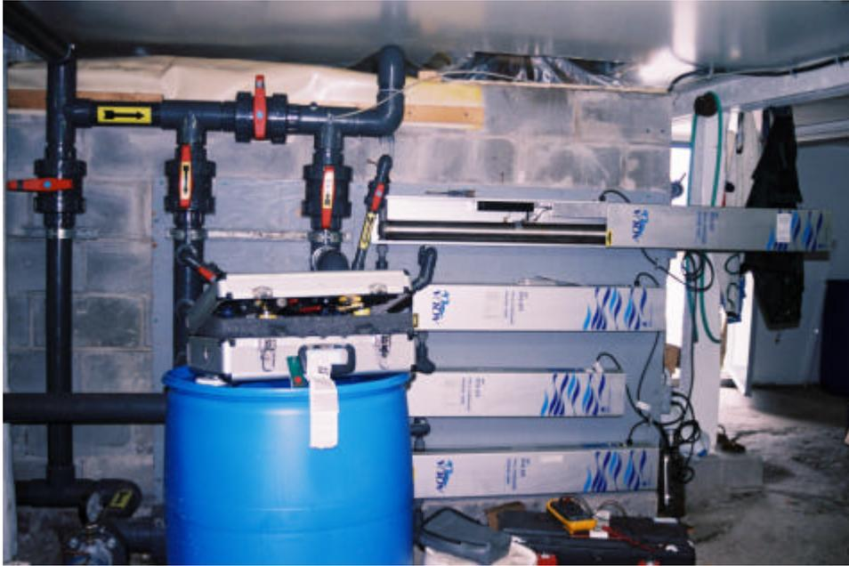
Photo B.14 Système UV en place à Harrington Harbour.
