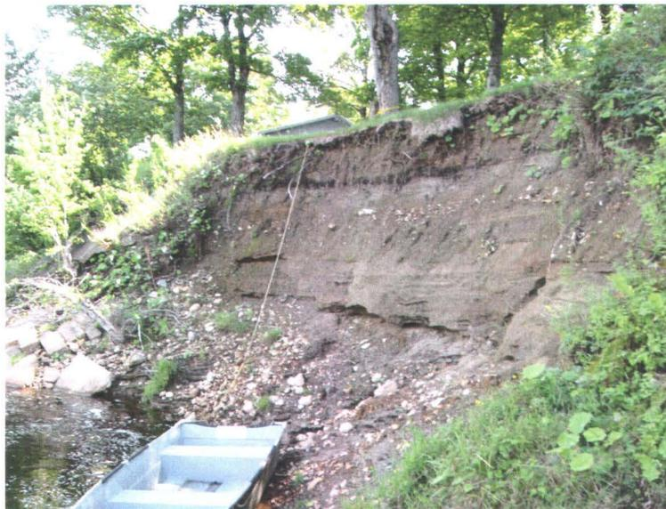
Figure 51 : Érosion des berges et perte de terrain par effondrement de berge, secteur de la rue des Trois-Saults (bornes 0,5 et 0,75).
