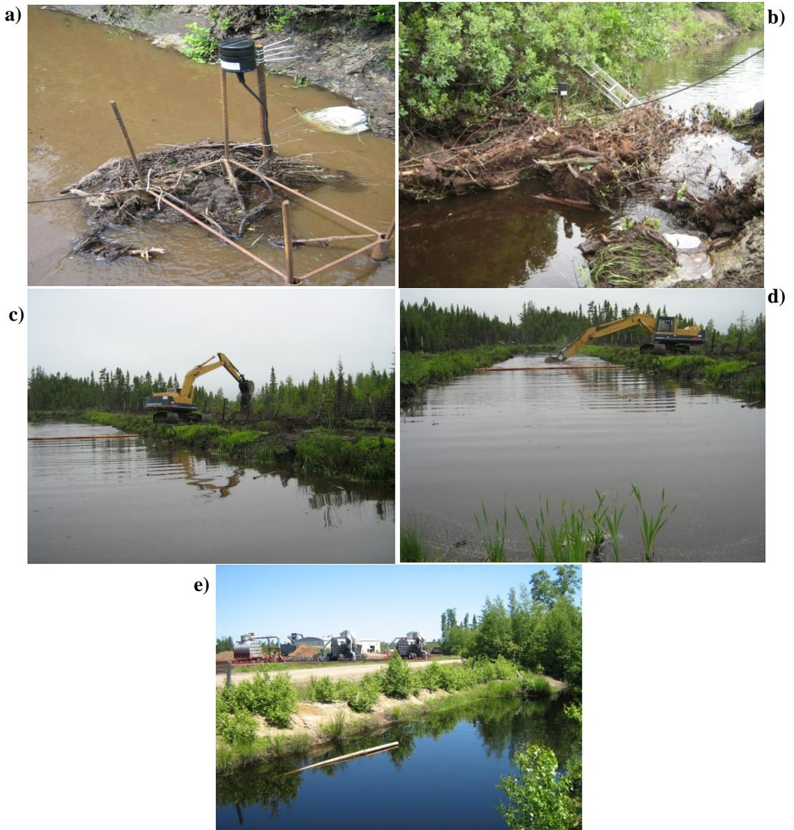
**Figure A-2 : a) et b) la station C3 en aval du bassin de sédimentation affectée par le dépôt des débris provenant des canaux de drainage et au voisinage de la station-tourbière de Rogersville. c) et d) procédé de nettoyage du bassin de sédimentation à l'aide d'une excavatrice et rejet des sédiments collectés aux alentours du bassin de la tourbière Hardwood, e) une bôme flottante mal placé dans le bassin de sédimentation de la tourbière de Rogersville.**
