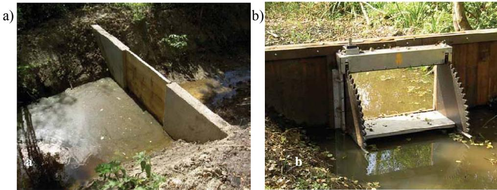
**Figure 1-6 : Barrage seuil avec a) seuil rectangulaire et b) régulation du niveau d'eau par une trappe (Vautier, 2007).**
