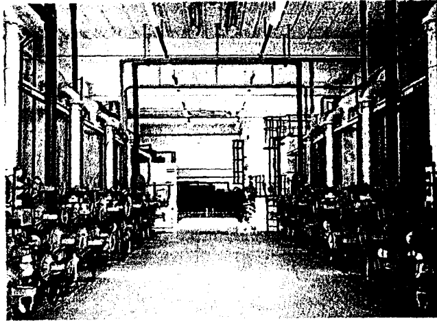
Figure 995. AÉROSPATIALE à MARIGNANE (Bouches-du-Rhône). Recyclage de bains électrolytiques — 2 chaînes d'échange d'ions avec résine de finition pour rétention de tensio-actifs. Débit: 2 \times 60 \text{ m}^3 \cdot \text{h}^{-1} .
