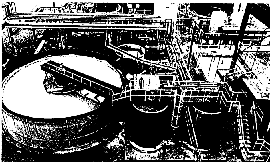
Figure 917. Vue générale de l'installation d'ARACRUZ (Brésil).
