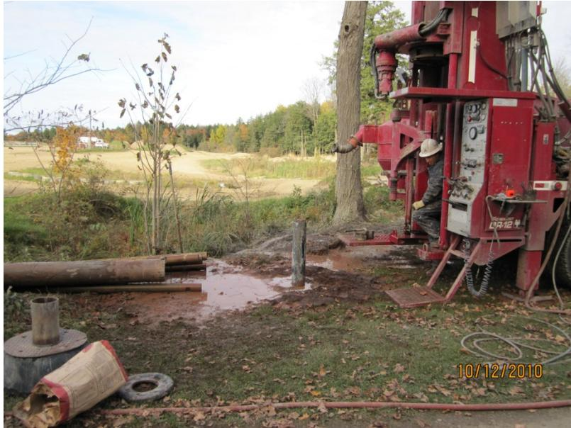
Figure 10 : Exemple d'une opération d'installation d'un puits d'observation
