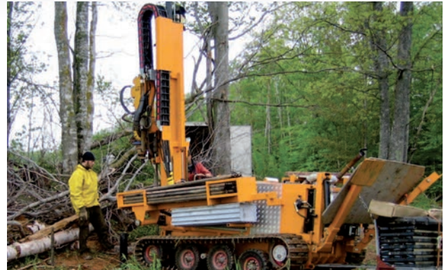
Foreuse Geotech sur le terrain
