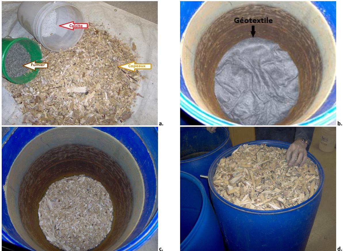
**Figure 9** Photographies illustrant les différentes étapes de construction des B2 : a. les différents composants du mélange, b. géotextile au fond du baril, c. mise en place d'une couche de copeaux en-dessous du biofiltre et d. mise en place d'une couche de copeaux au-dessus du biofiltre
