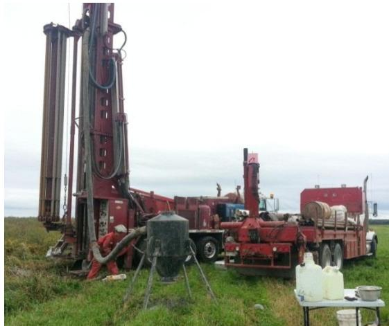
**Figure 3 Forage des puits par la méthode destructive (puits F5).**
