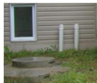
Figure 5: Type de drains et cheminées de regard proposés par la norme.
