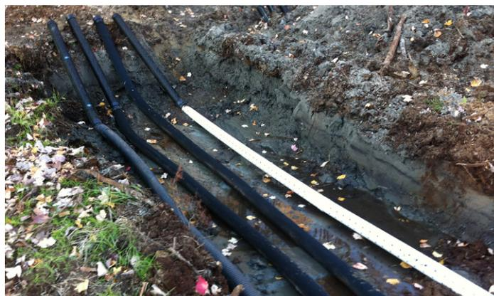
Figure 7: Les quatre types de drains testés.
