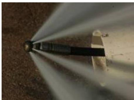
Figure 4: Furet hydraulique utilisé pour le nettoyage des drains.
