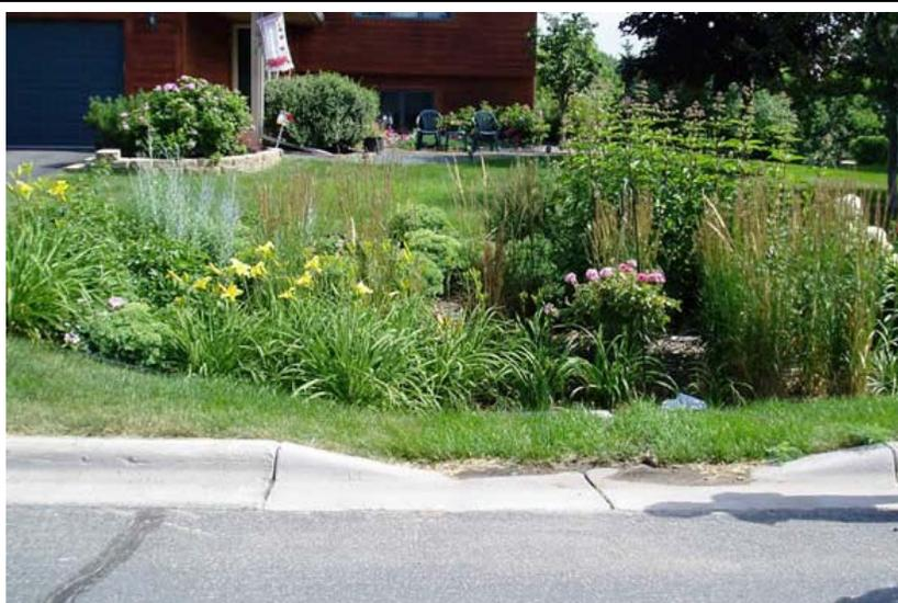
Figure 2. Système de bio-rétention dans un secteur résidentiel
