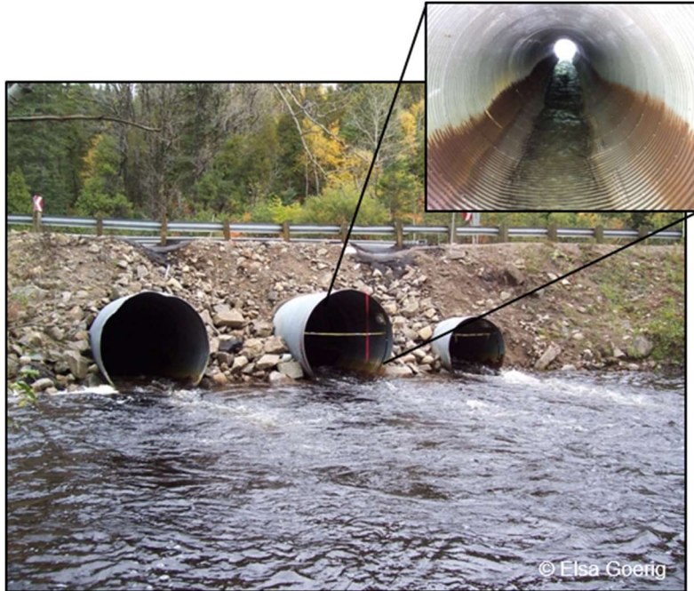
Figure 7. Site d'étude constitué de trois conduites en tôle ondulée galvanisée. Médaille : intérieur de la conduite utilisée pour l'étude.
