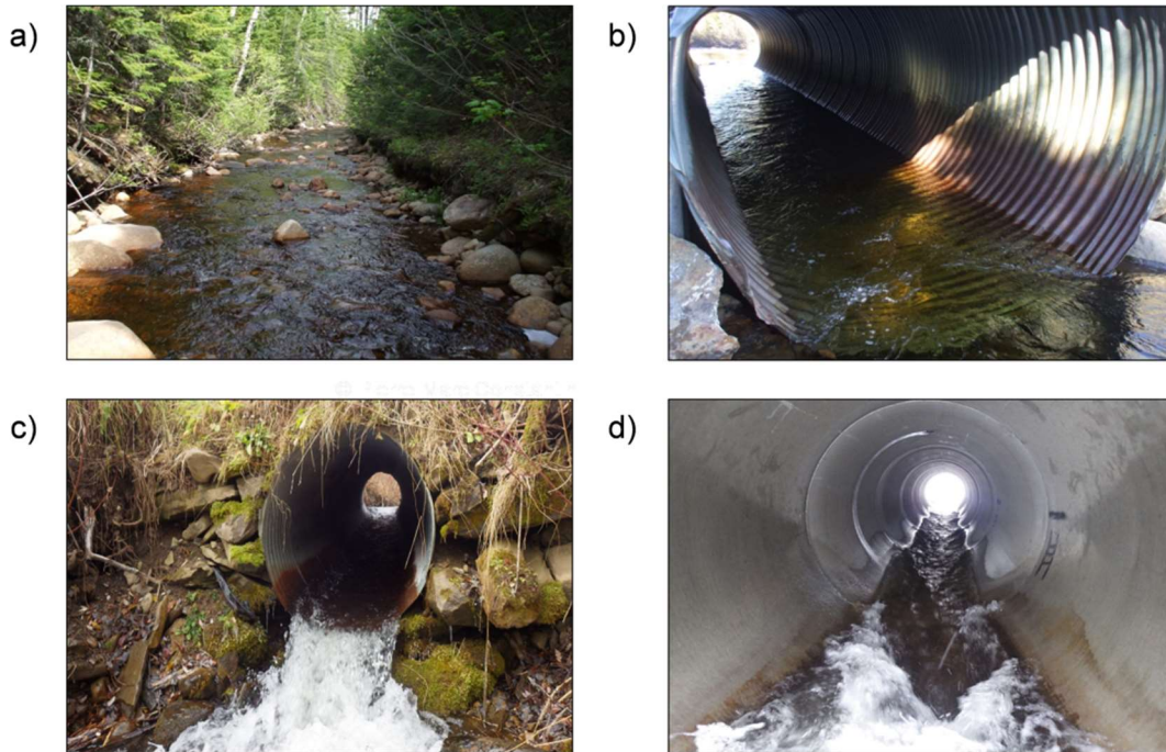
Figure 1. Les ponceaux en tant qu'obstacle à la libre circulation des poissons: a) cours d'eau à son état naturel; b) ponceau en tôle ondulée avec impact modéré; c) ponceau avec chute infranchissable; d) ponceau lisse en béton avec vitesse d'écoulement rapide et pente élevée.
