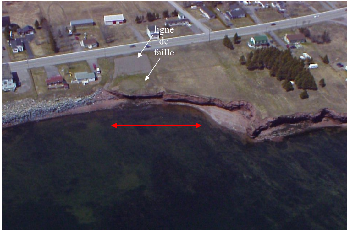
Figure 7.15 : Zone présentant l'IVC le plus élevé du secteur de Pabos. Cette zone cumule une base particulièrement exposées aux vagues, une encoche profonde et la proximité d'une faille.
