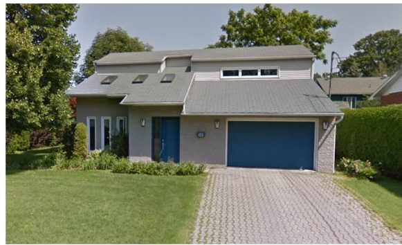
Maison sans sous-sol, avec étages (Rue Parenteau, Saint-Jean-sur-Richelieu)
