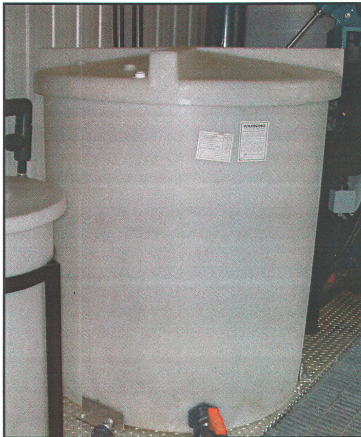
Figure 2 Bassin de réaction de l'usine pilote où ont été appliqués les traitements Metix-AC et Stabiox sur les boues d'épuration de Valcartier
