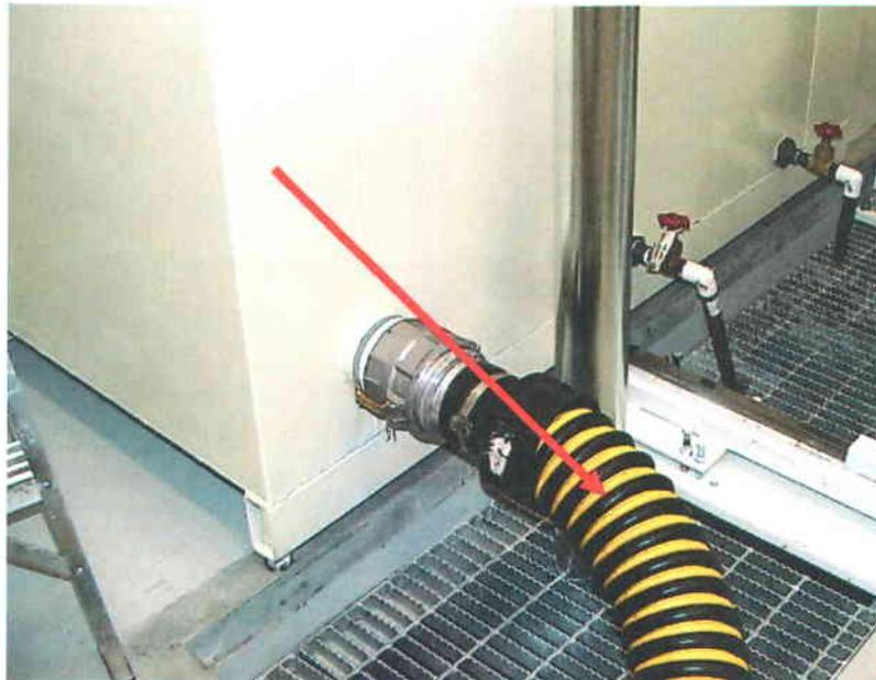
Figure 151. Photographie représentant les conduites flexibles installées dans la boucle de recirculation de la pompe.
