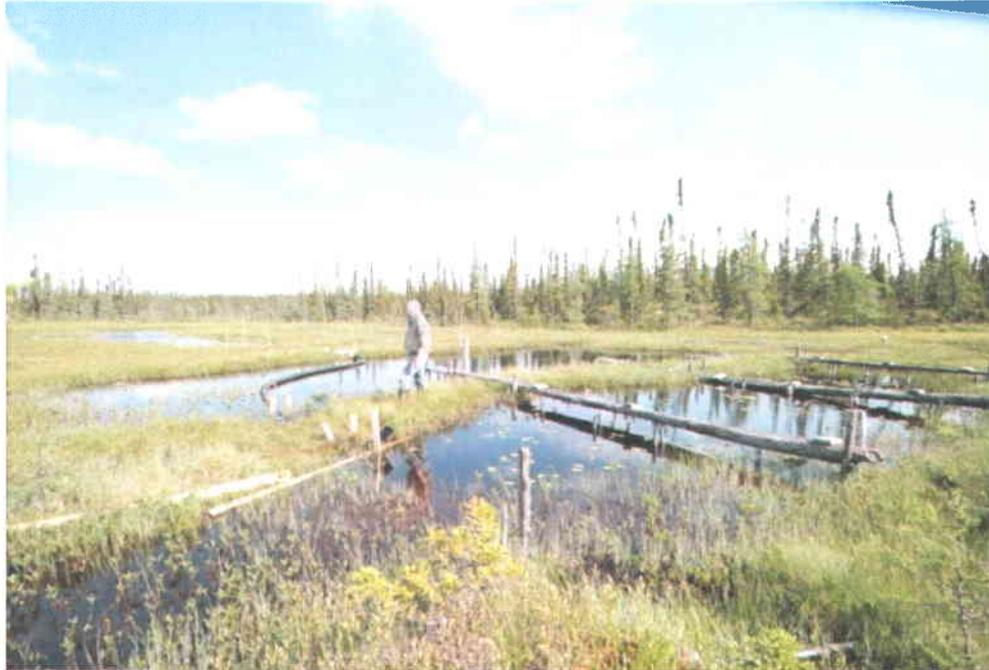
**Figure I.11 : Photo du système de drainage des mares. Le drain est repérable à gauche de la personne, au niveau des pieux verticaux en bois.**
