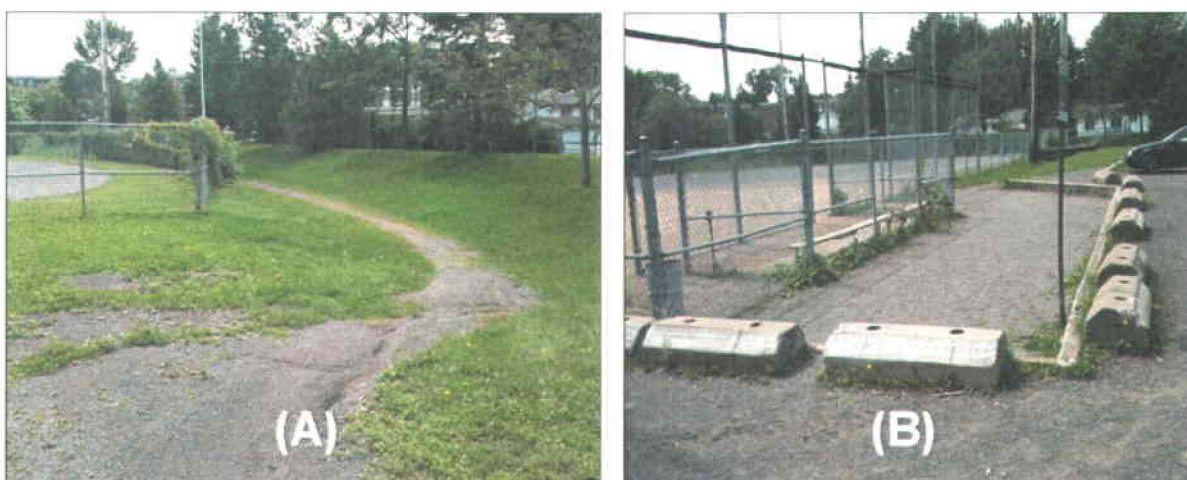
Figure 3.4 : Circulation d'eau vers le bassin : les traces de la force de la pluie (A) et aménagement pour protéger le stationnement en face du terrain de baseball adjacent au parc (B).
