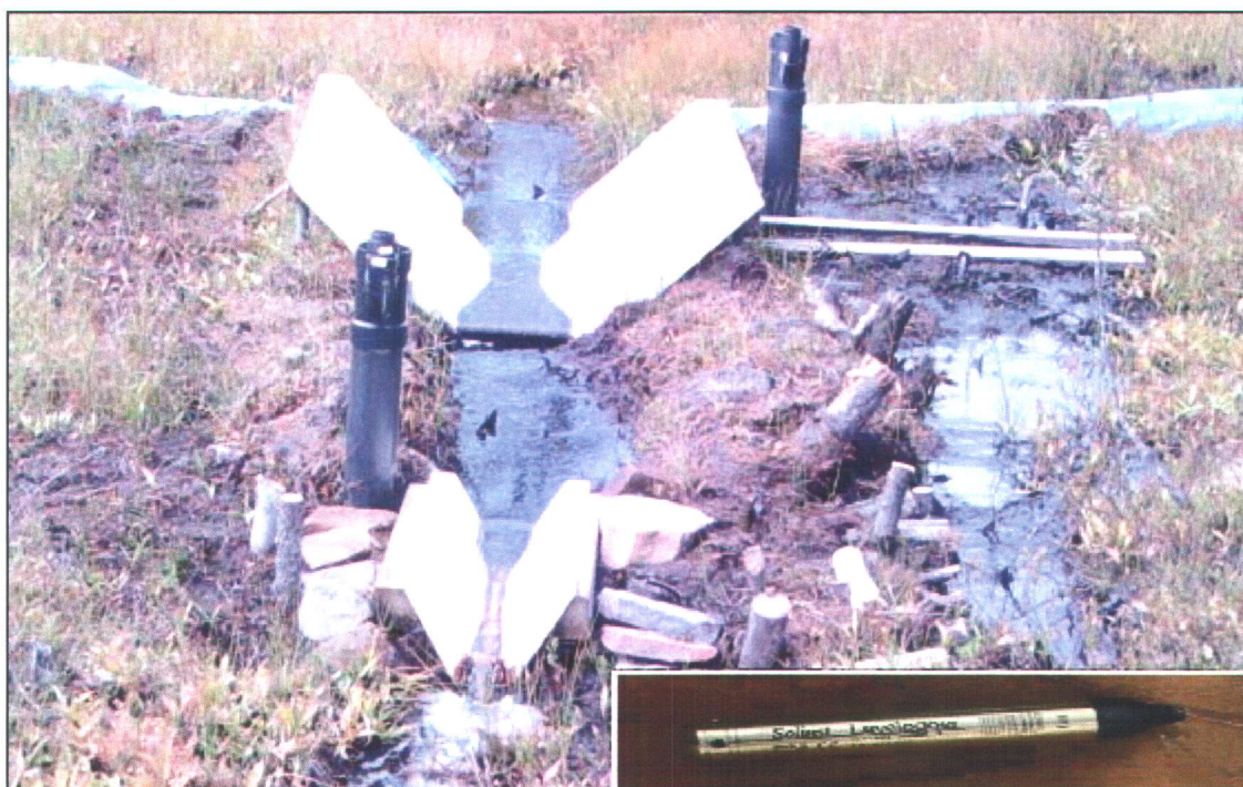
Figure 4-3. Position des deux canaux trapézoïdaux, chacun reliés à un puits contenant une jauge à pression hydrostatique (Solinst). Cette figure présente le ruissellement de l'eau à travers les canaux en période d'été.
