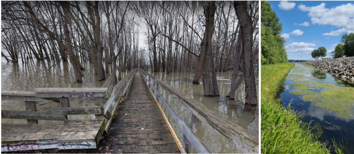
Figure 5.9 : Passerelle dans le parc de la Frayère en avril 2017 avant sa reconstruction (à gauche) et travaux de stabilisation de la digue effectués en 2020 (à droite)
