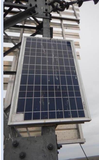
Panneau solaire en bon état
