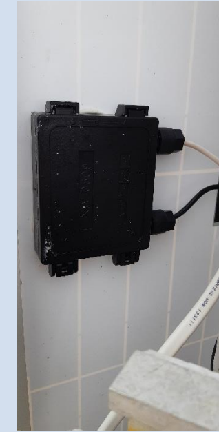
Branchement du panneau solaire en bon état
