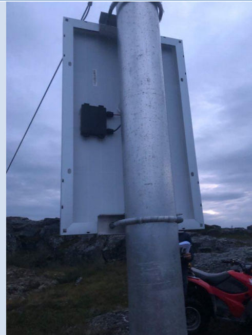
Branchement du panneau solaire intact
