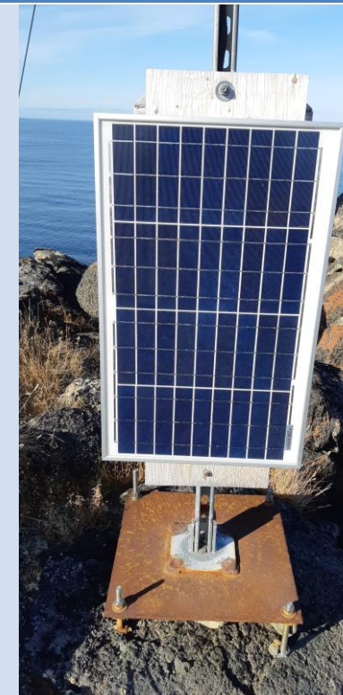
Panneau solaire en bon état
