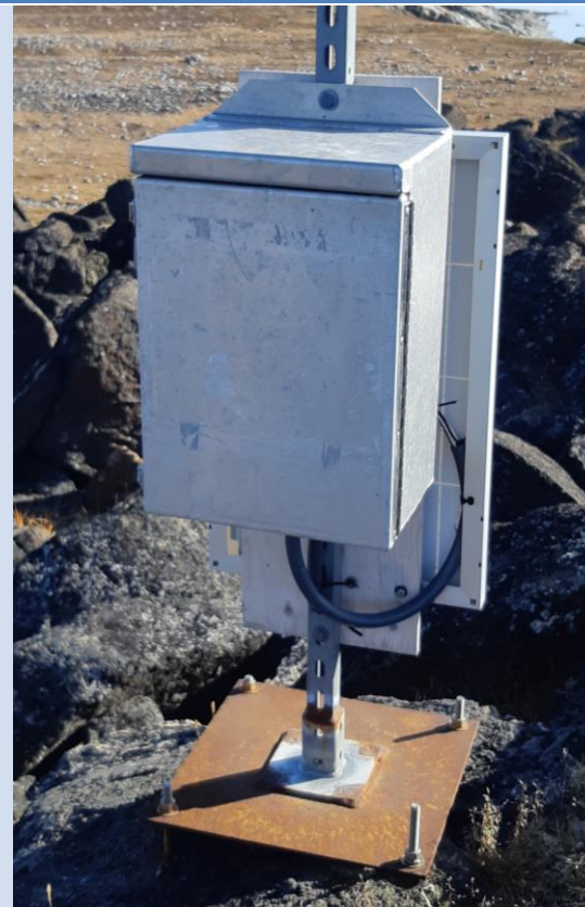
Boitier et structure en bon état
