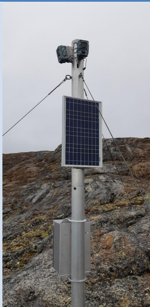
Système en bon état
