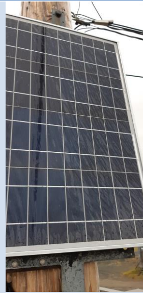
Panneau solaire en bon état
