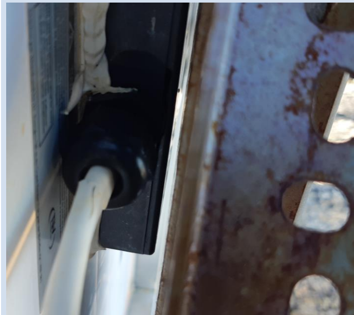
Connexion au panneau solaire en bon état
