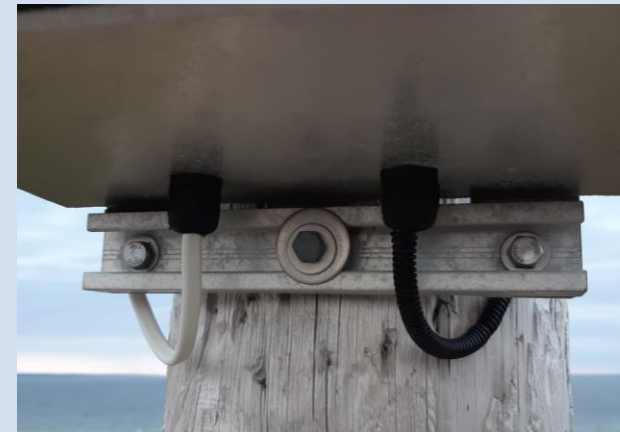
Entrée des fils en bon état
