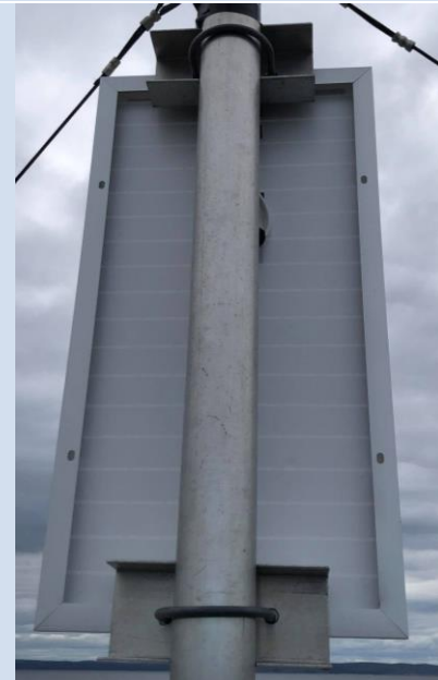
Branchement du panneau solaire semble intact
