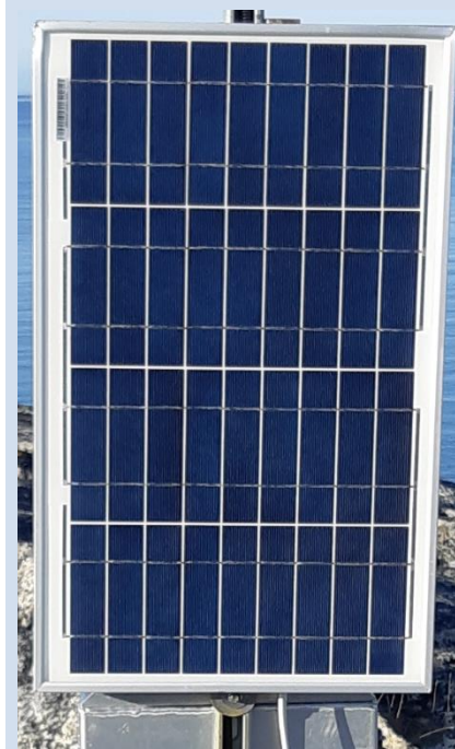
Panneau solaire en bon état
