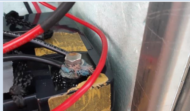
Présence de vert de gris sur le pôle d'une batterie
