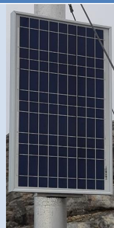
Panneau solaire en bon état
