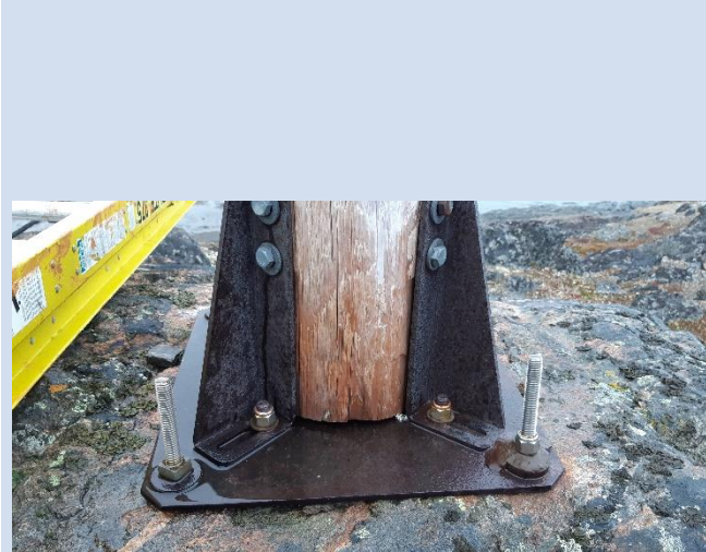
Base et structure toujours en bon état
