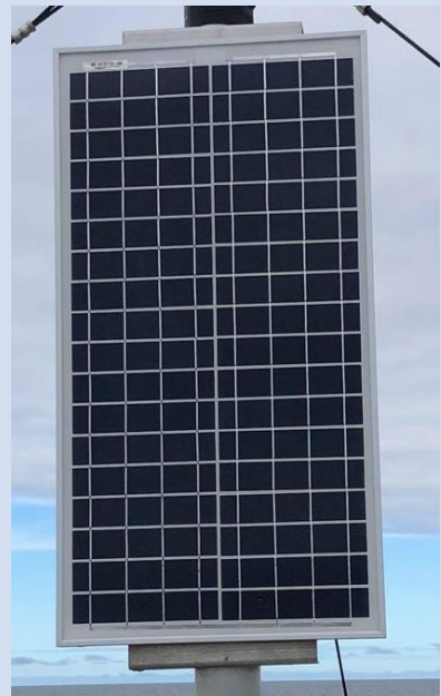
Panneau solaire en bon état
