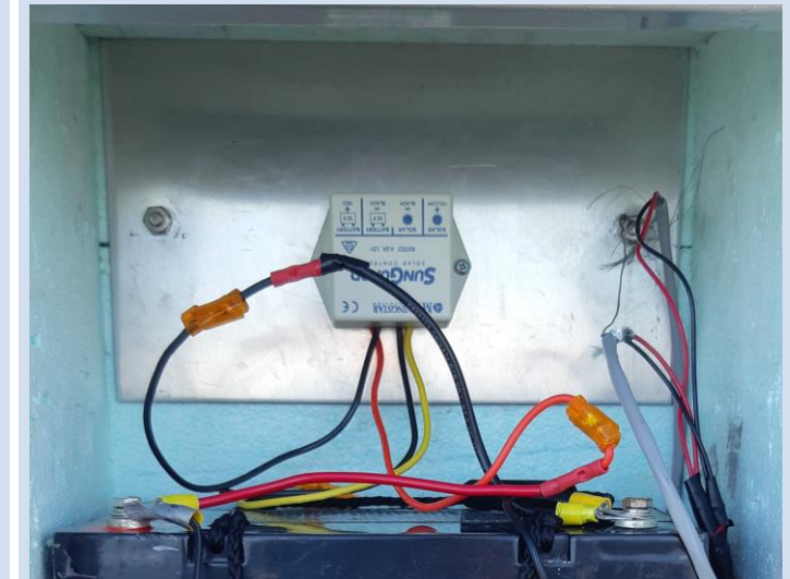
Connexions en bon état
