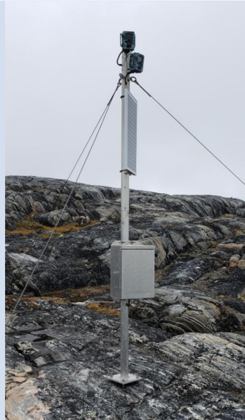
Structure en bon état avant le retrait
