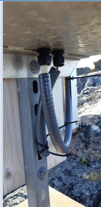
Protection des fils toujours en place et en bon état
