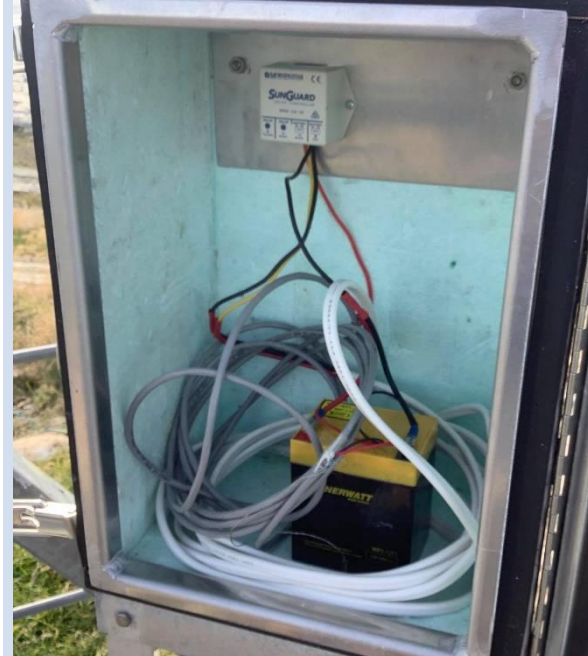
Batterie et connecteur en bon état
