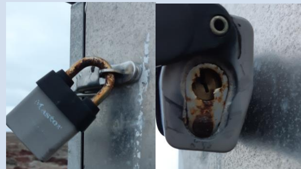
Cadenas présentant des signes de corrosions sur l'anse mais le mécanisme est en bon état
