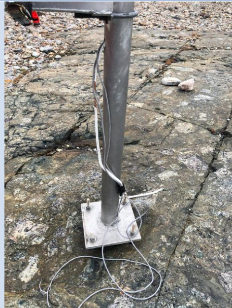
Fils du panneau solaire et des caméras arrachés sous le boîtier en aluminium
