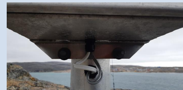
Câblage en bon état
