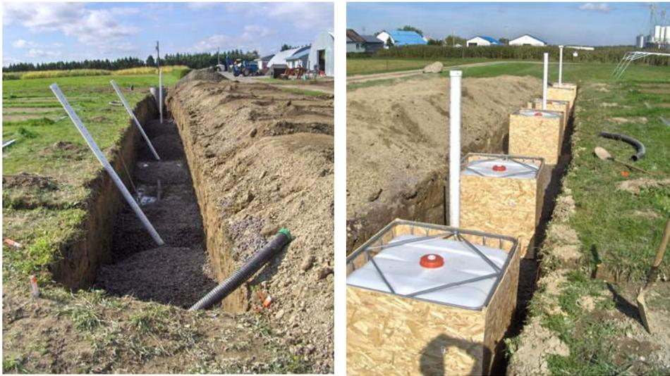
Figure M.6 : Installation des regards et des réservoirs
