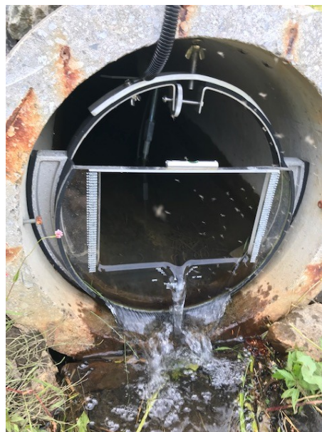
Figure 3.13 : Déversoir à insertion installé à IN3 au BSC
