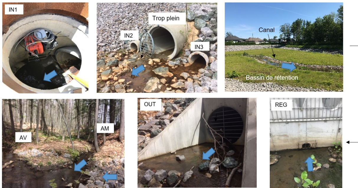
Figure 3.7 : Cheminement de l'eau de l'entrée du BSC jusqu'au milieu récepteur au site TR
