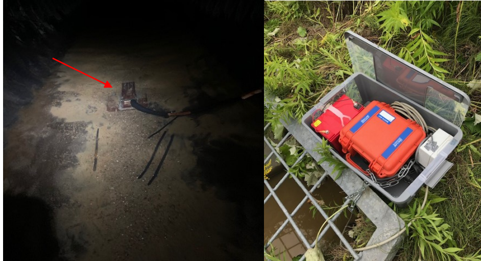
Figure 3.11 : Installation du débitmètre et de sa sonde au point IN du BS
