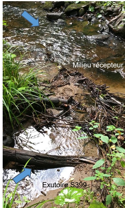
Figure 4.31 : Exutoire de l'ouvrage S399 en temps sec (débit d'infiltration)
