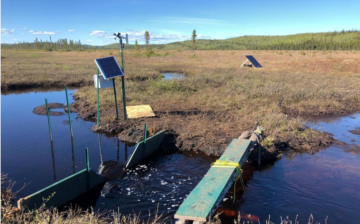
Figure 21 : Équipements installés à l'exutoire de la tourbière Bouleau : le seuil en V, les Panneaux solaire, et le pyranomètre
