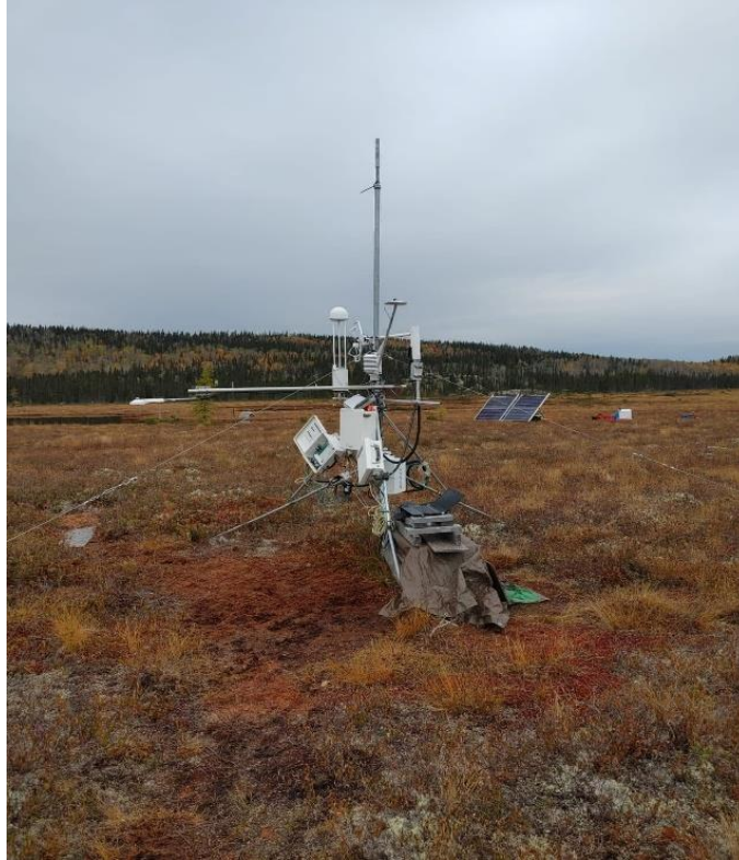
Figure 8: Le mât micrométéorologique (aussi appelé la tour Eddy covariaance) permettant les mesures des paramètres météorologiques sur la tourbière Bouleau
