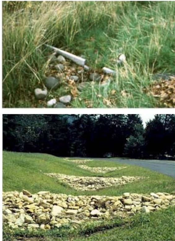
**Figure 8.3 Exemple de dépression gazonnée (« grass swale ») comportant des digues (« check dams ») (tiré de DEP, 2006)**
