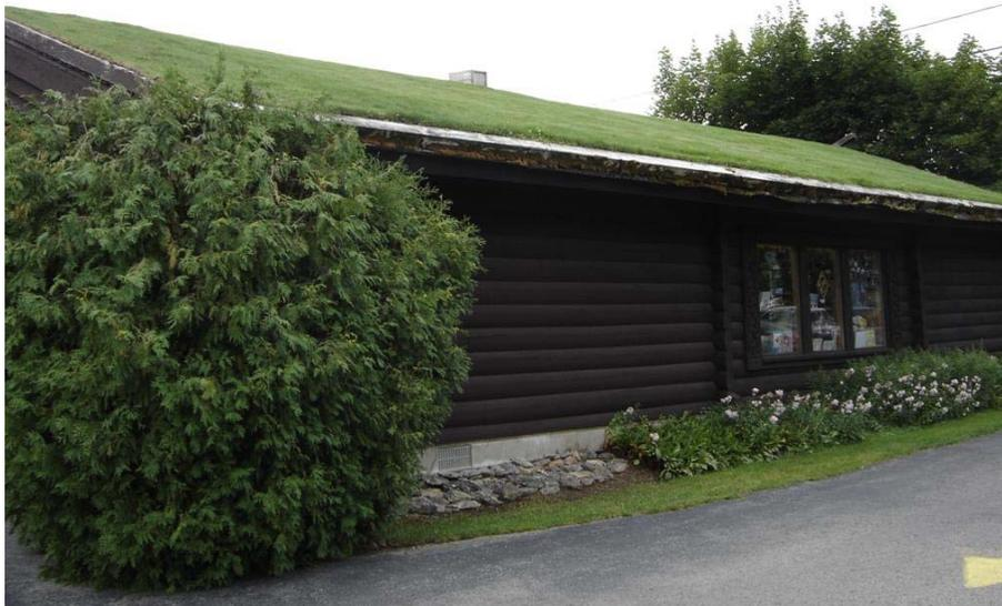
**Figure 6.1 Exemple de toit vert extensif.**
