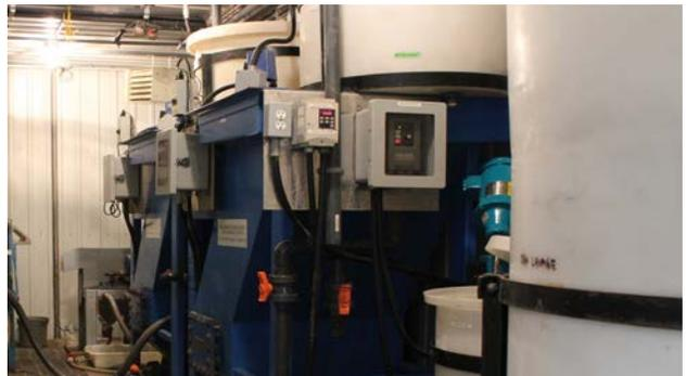
Décanteurs lamellaires avec instrumentation
