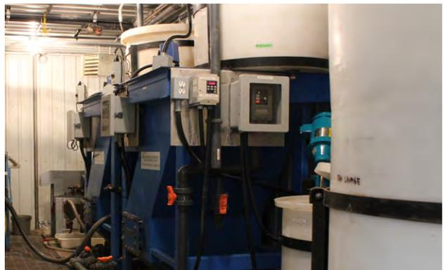
Décanteurs lamellaires avec instrumentation
